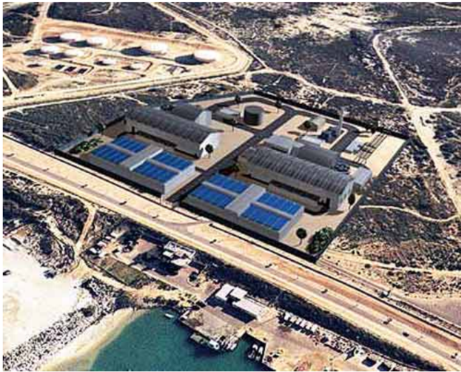
Sl. 7. Ashkelon postrojenje: Izrael, investicija: 212 mil. $; površina: 75,000 m 2 , kapacitet: 330 000 m 3 /dan, 110 mil. m 3 /god, parametri: c_{ulaz} = 40700 ppm TDS, R=99,9\% ; cijena vode: 0,527 $/m 3 ; troškovi energije: 4 kWh/ m 3
